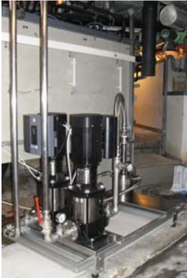
Abbildung 4 und 5: Einsatz- beispiel BALS Liquid Legio Nanotherm in einem Schwimm- bad. (Zirkula- tionskreislauf).
