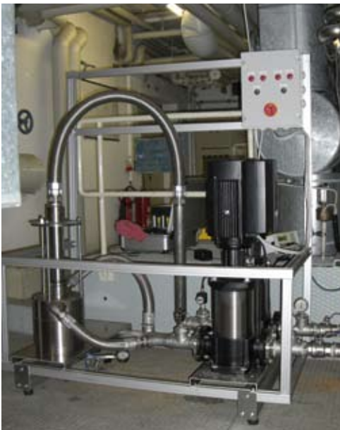
Bild 2 und 3: Einsatzbeispiel BALS Liquid System Legio Nanotherm in einem Krankenhaus (Bypass Speicher).
